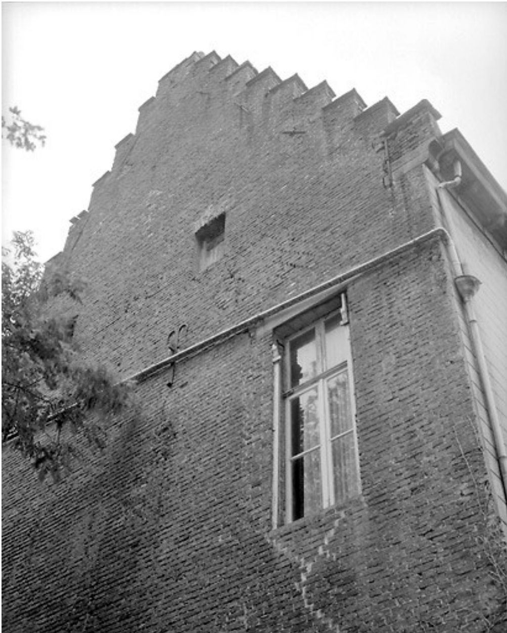
Mur pignon côté nord-ouest : détail, vue de la partie supérieure.
