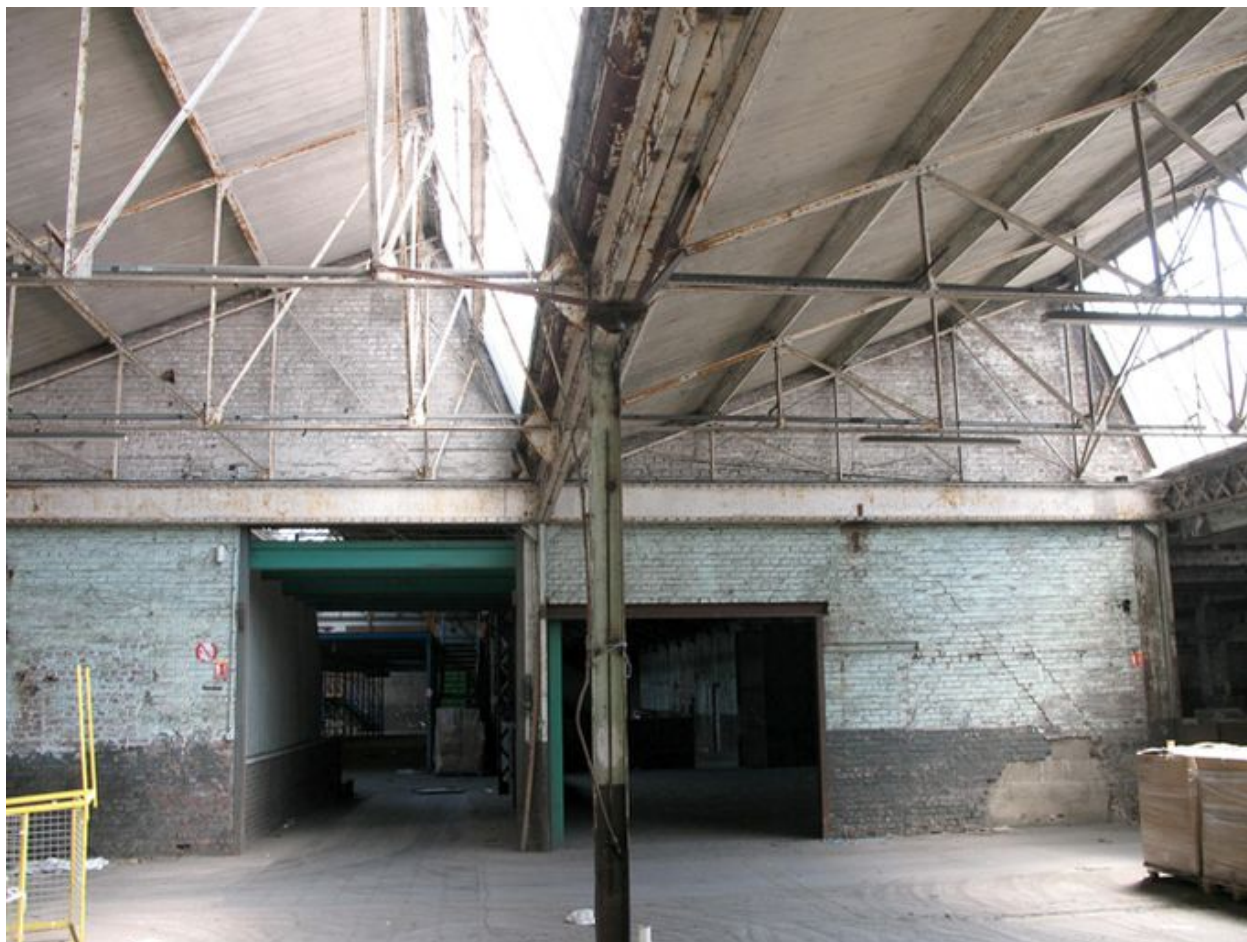
Détail des travées couvertes en sheds.
