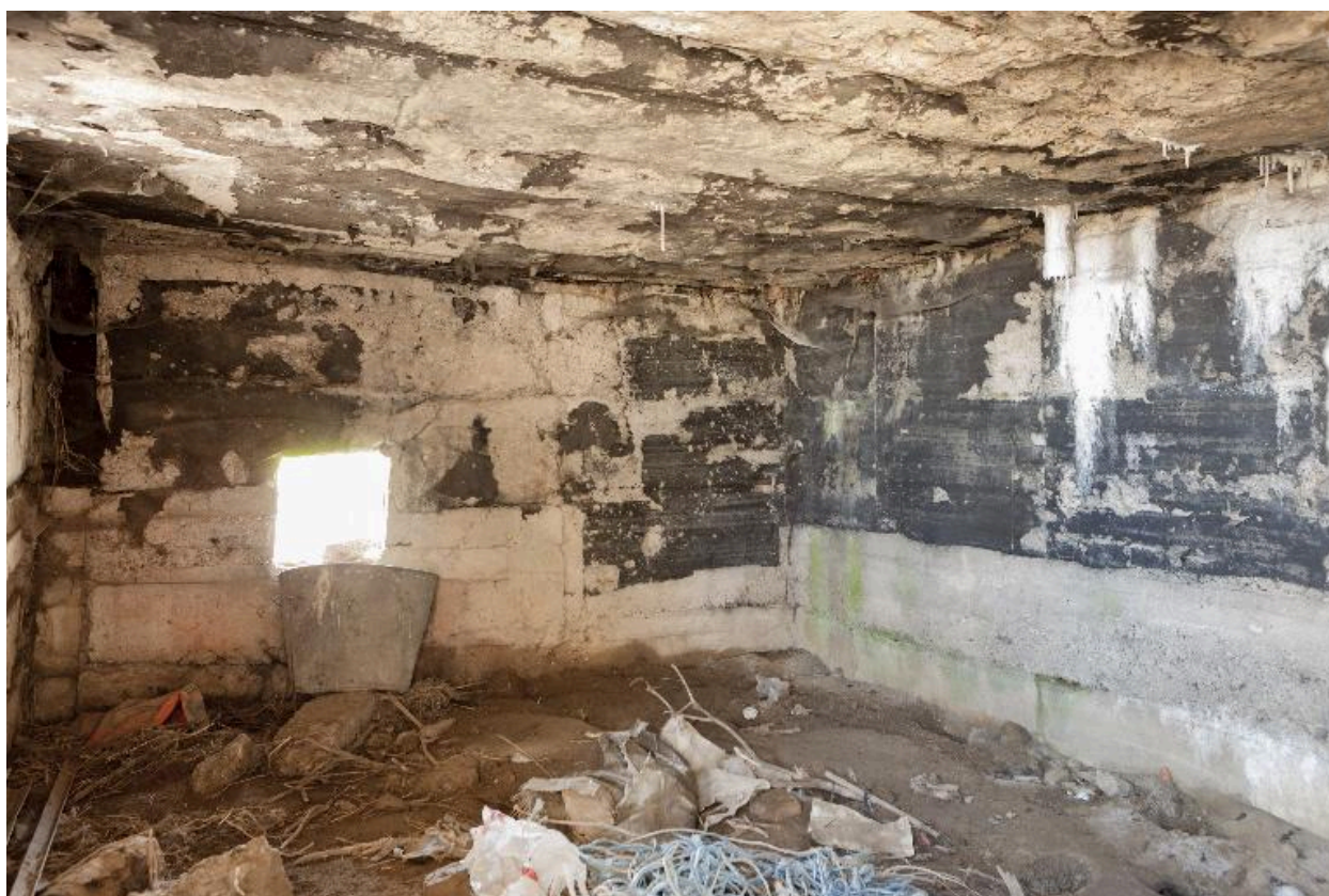
Bâtiment 4, vue intérieure
