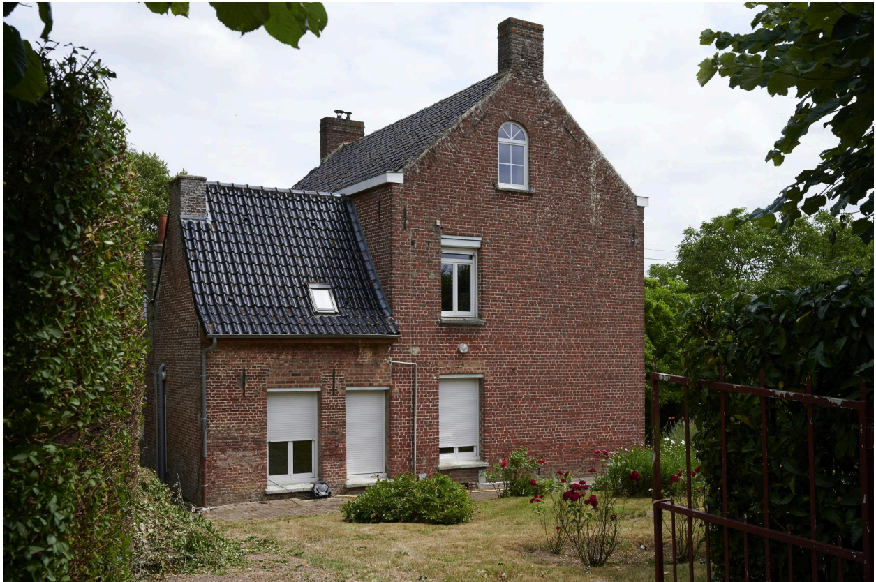
Pignon sud-ouest et annexe.
