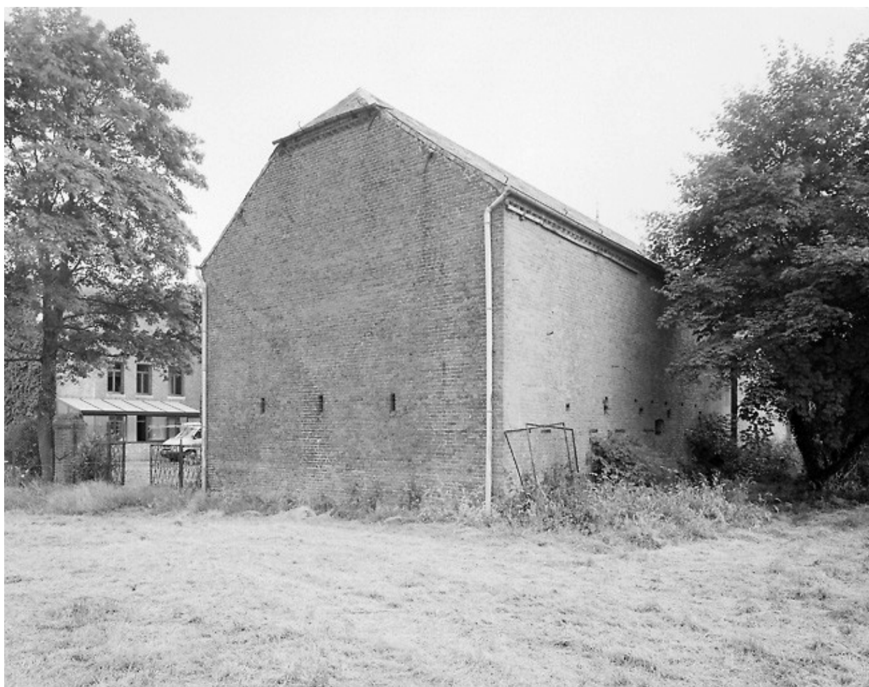
Vue du pignon de la grange.
