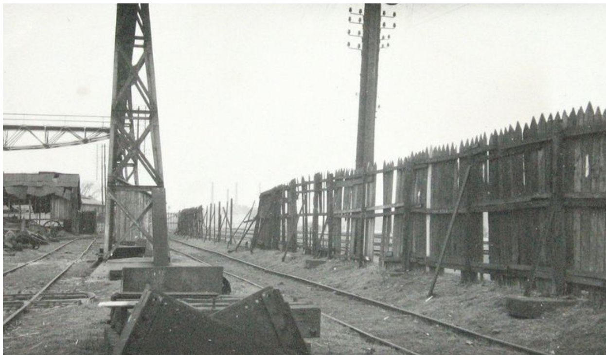
Clôture de la propriété Joret après les bombardements de 1944. A l'arrière-plan, les cheminées de l'usine de zinc de la Vieille-Montagne (AD Oise ; 617W18128).
