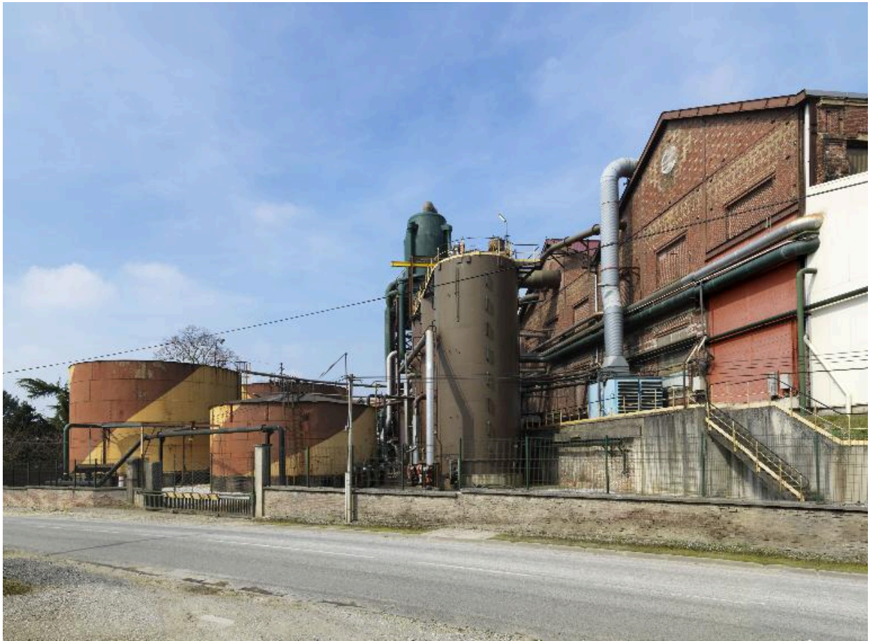
Pignons de l'atelier principal de la sucrierie.
