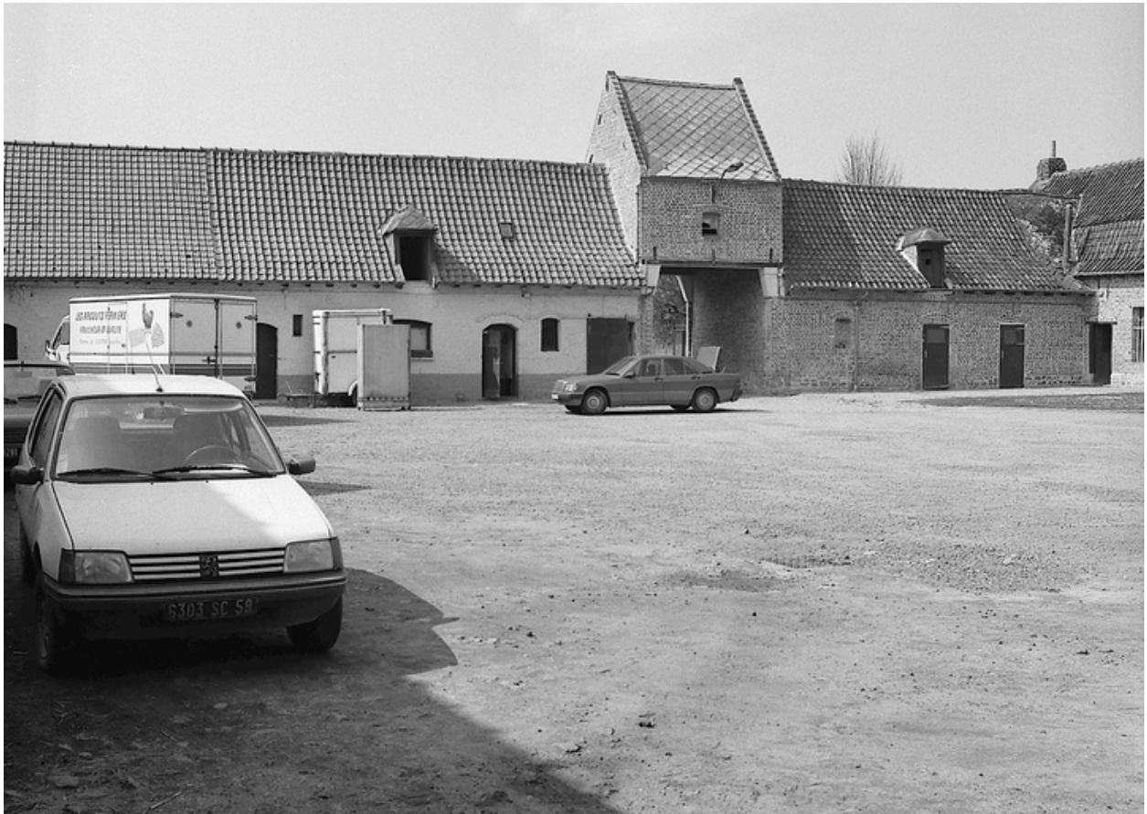
Vue générale intérieure de la cour ; le pigeonnier-porche.
