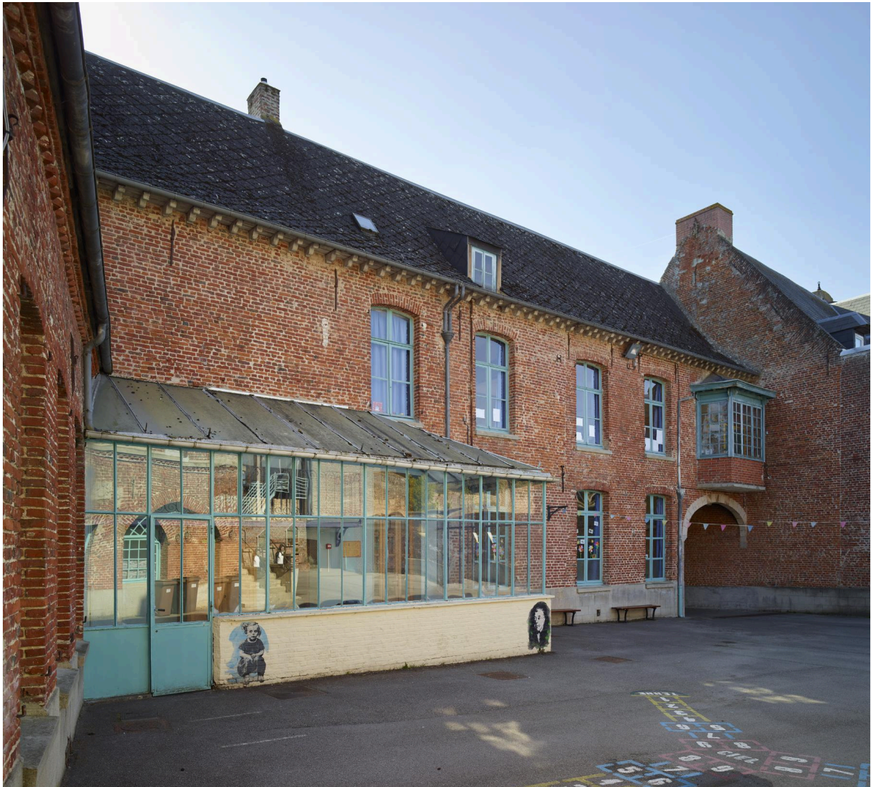
Vue de la façade arrière de l'aile principale sur la rue de la Couronne, depuis la cour de l'école primaire Chevray. Vue orientée sud/nord.
