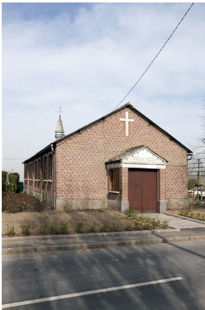
Élévation antérieure et flanc gauche.
