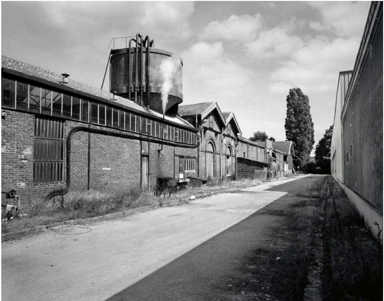
Vue d'ensemble des ateliers de teinture et du château d'eau.
