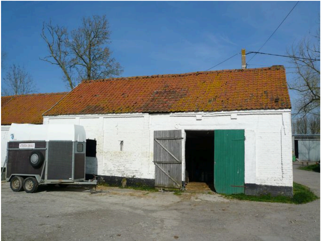
Vue des étables à l'entrée de la cour à l'est.
