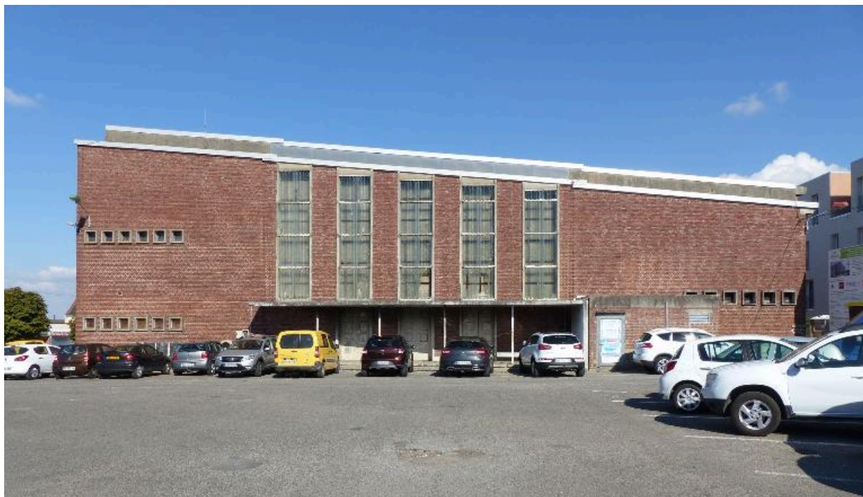
Vue de la façade sud de la salle des fêtes.
