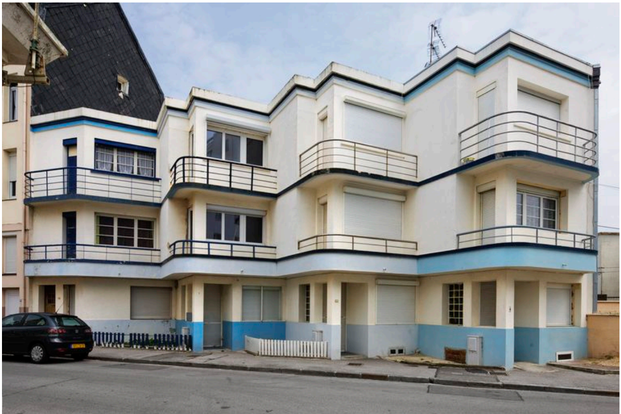
Vue générale d'une série d'immeubles de la reconstruction, rue du Calvaire.
