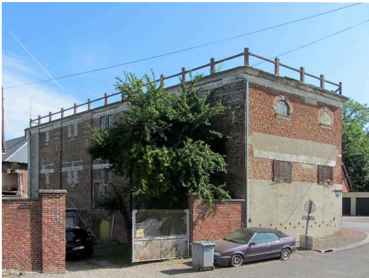
Façade postérieure du moulin à farine.
