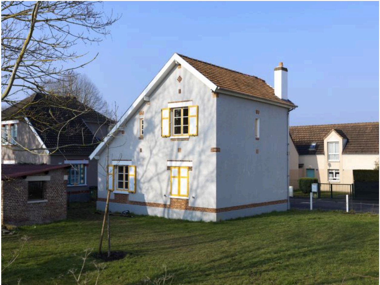
Maison. Rue des Tilleuls.
