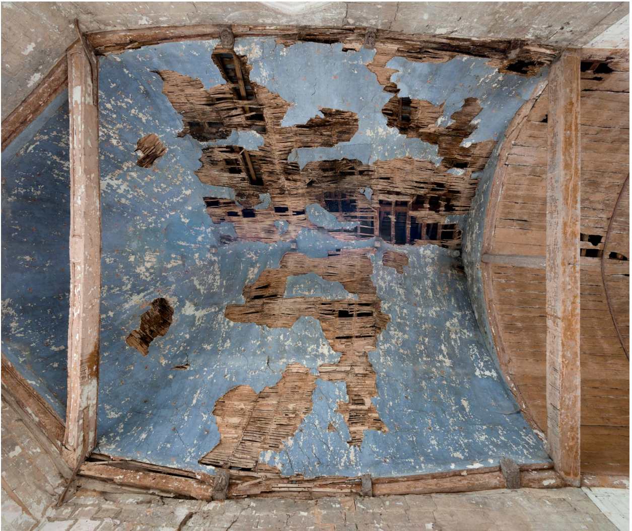
Voûte lambrissée du chœur, vue en contre-plongée.
