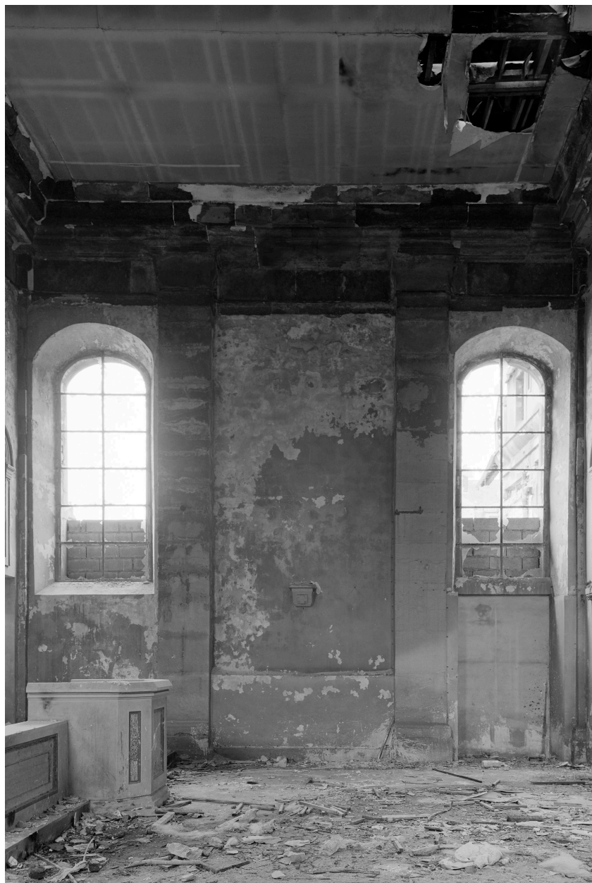
Chapelle, transept est, fenêtres.
