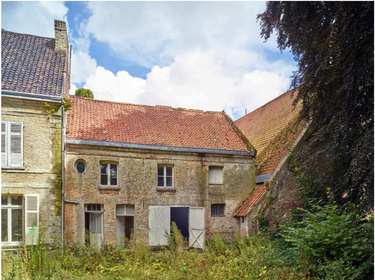
Ferme des Berceaux en 2018 : partie ouest de la ferme : détail de la façade de la remise depuis le jardin.
