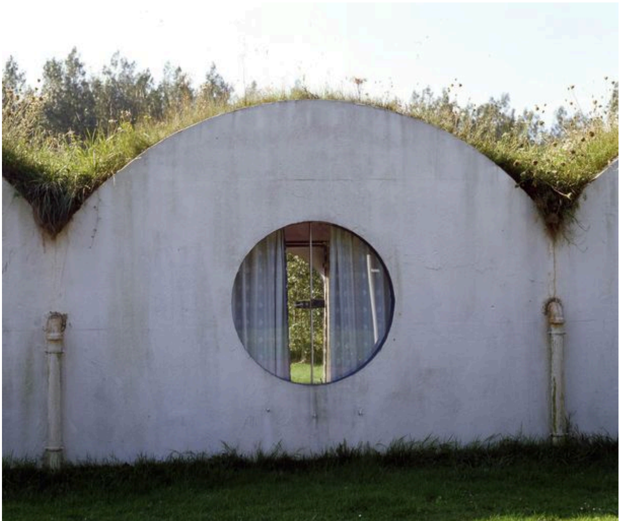
Détail d'un bungalow, élévation postérieure.
