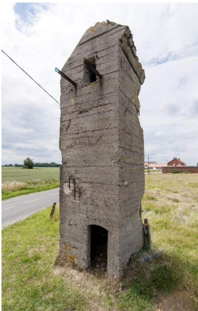
Vue de trois-quarts de l'observatoire vers l'ouest
