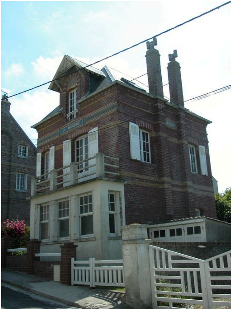
Vue d'ensemble depuis la partie basse de la rue.
