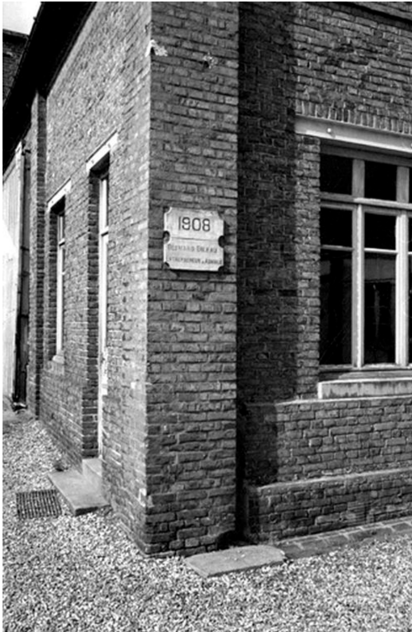
Cheminée d'usine, salle des machines, transformateur.
