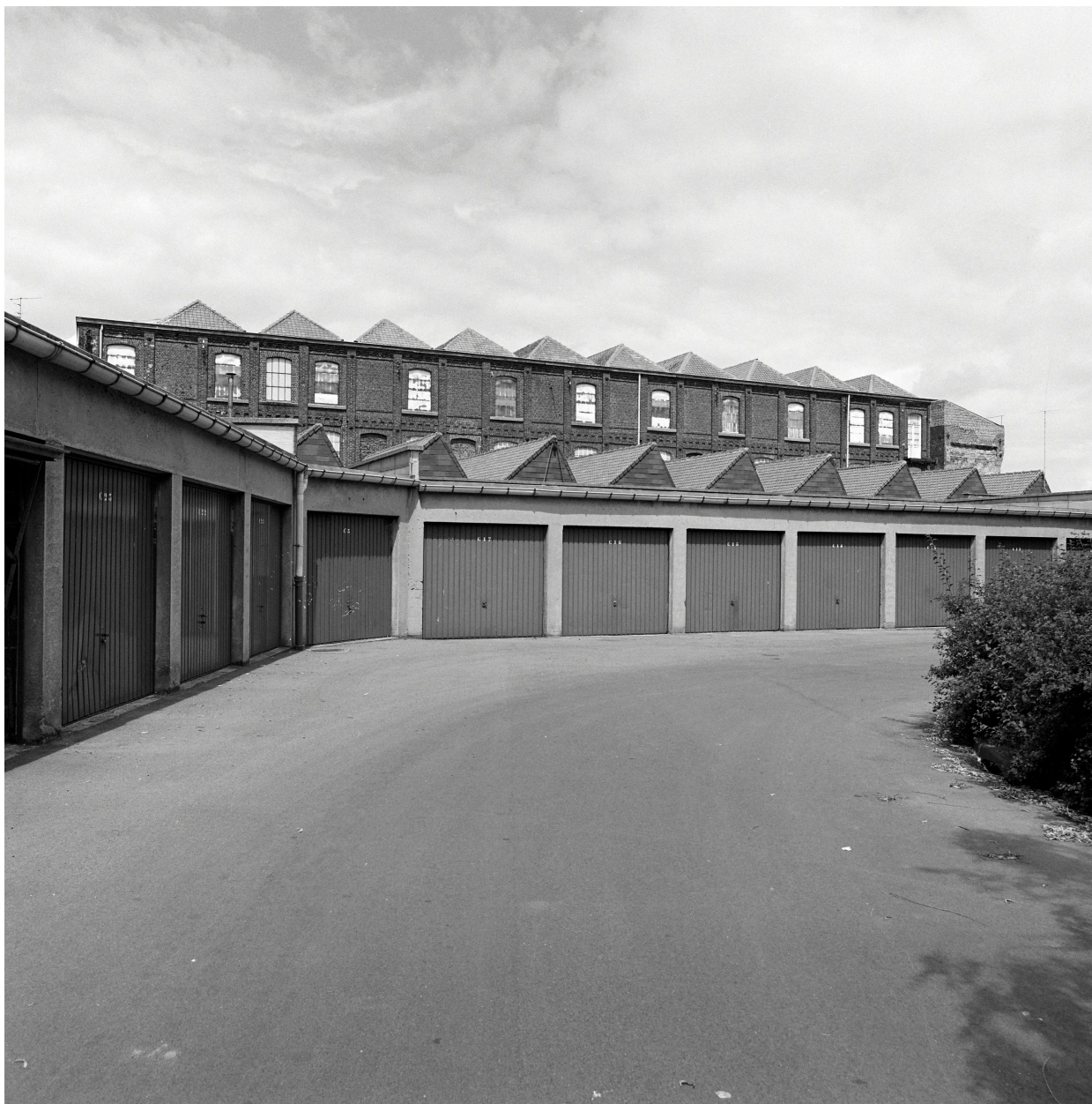
Atelier de fabrication, élévation sud.
