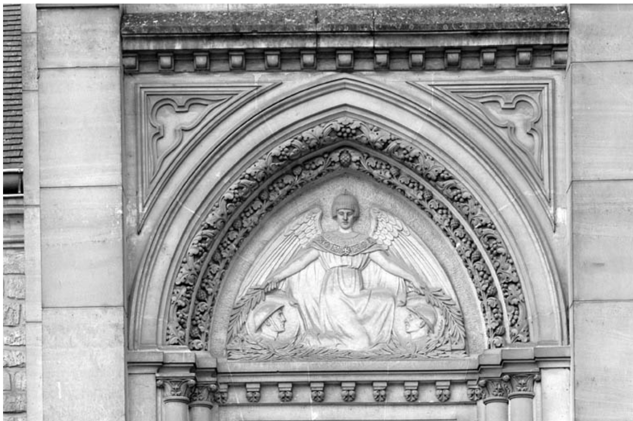
Le tympan surmontant la porte d'entrée, H. Vallette, vers 1920, vue d'ensemble.
