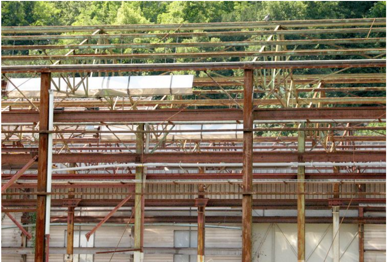
Détail de la charpente métallique.
