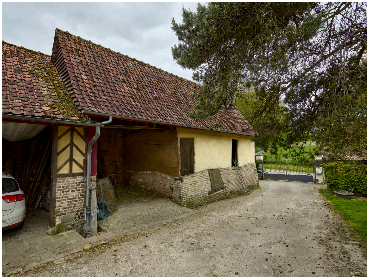
Vue de l'ancienne grange, depuis la cour.
