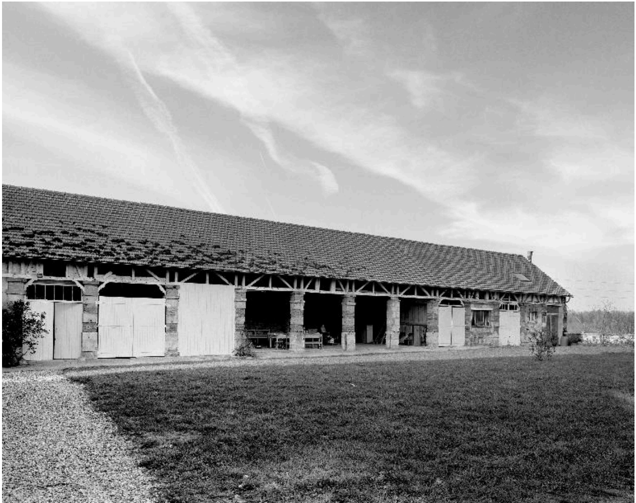
Élévation sur cour des remises.
