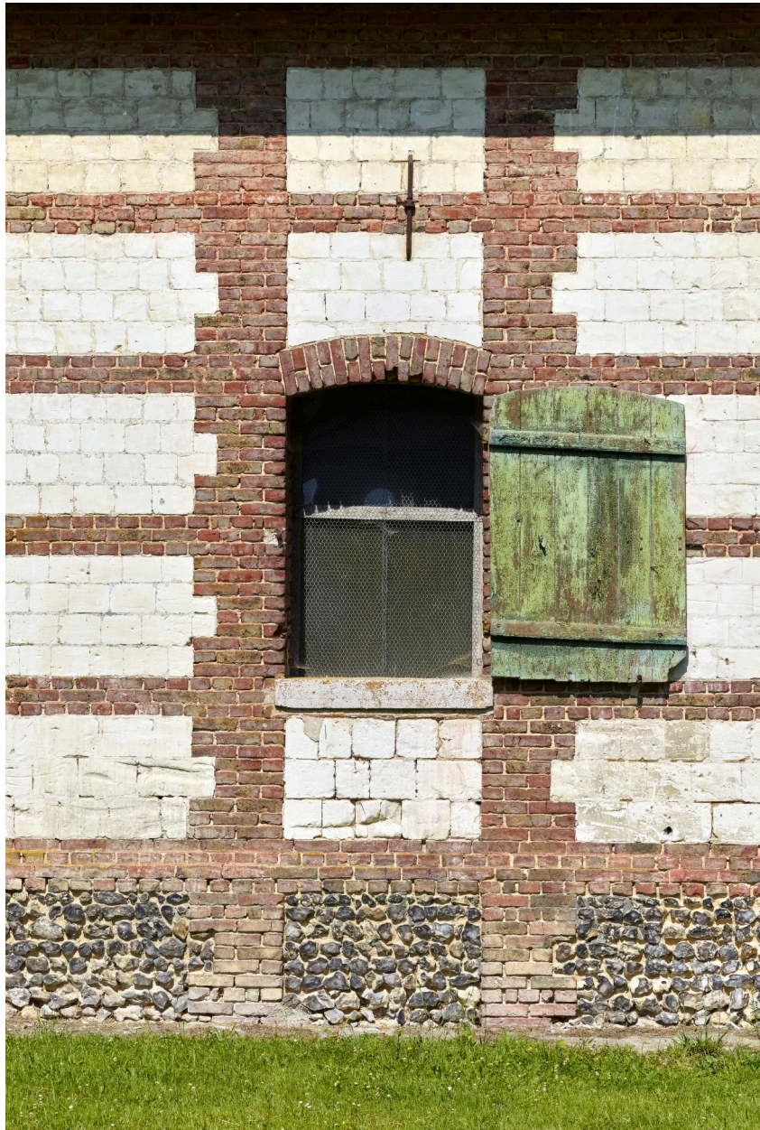
Détail de l'appareil du magasin à fourrage de la ferme du château, construit en 1875 (date portée).
