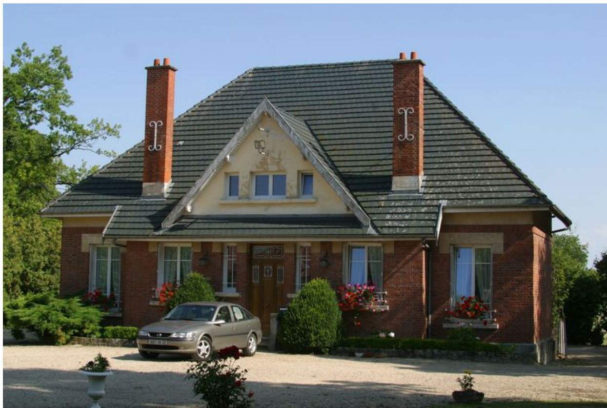
Vue sur cour du logement du gardien.
