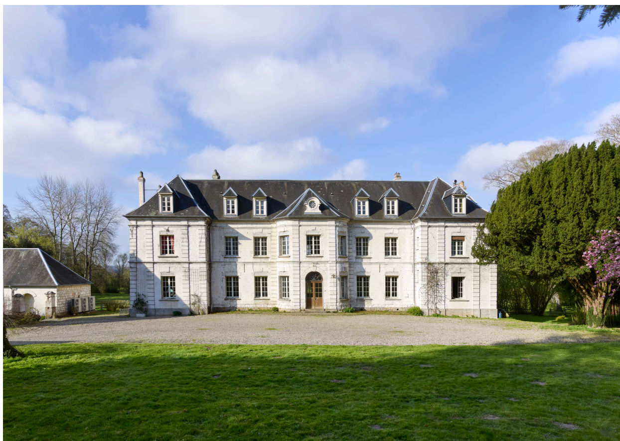
Façade nord du château.
