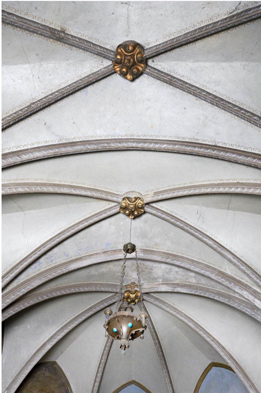
Détail du plafond et des voutes.
