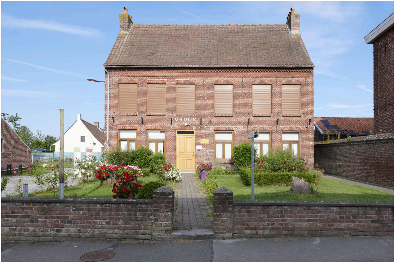
Façade principale de la mairie.
