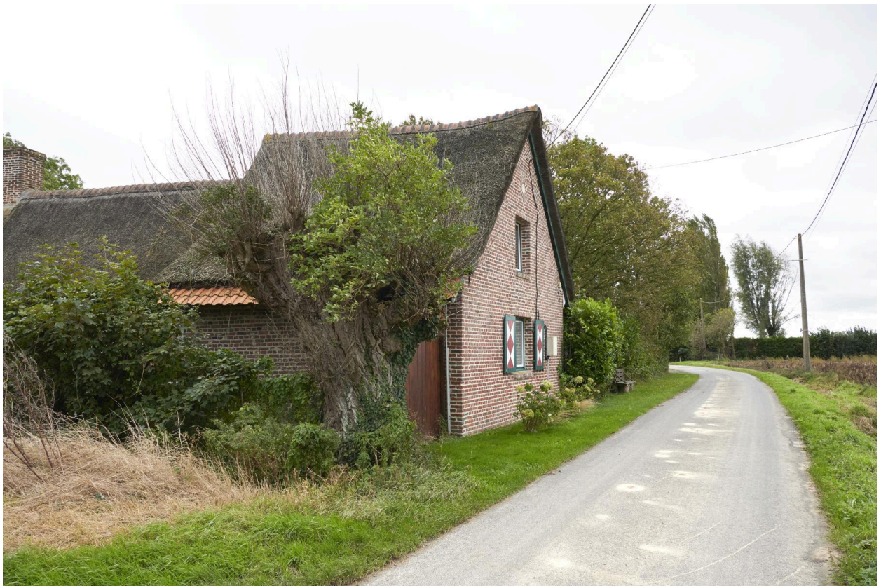
Détails du pignon ouest sur rue.
