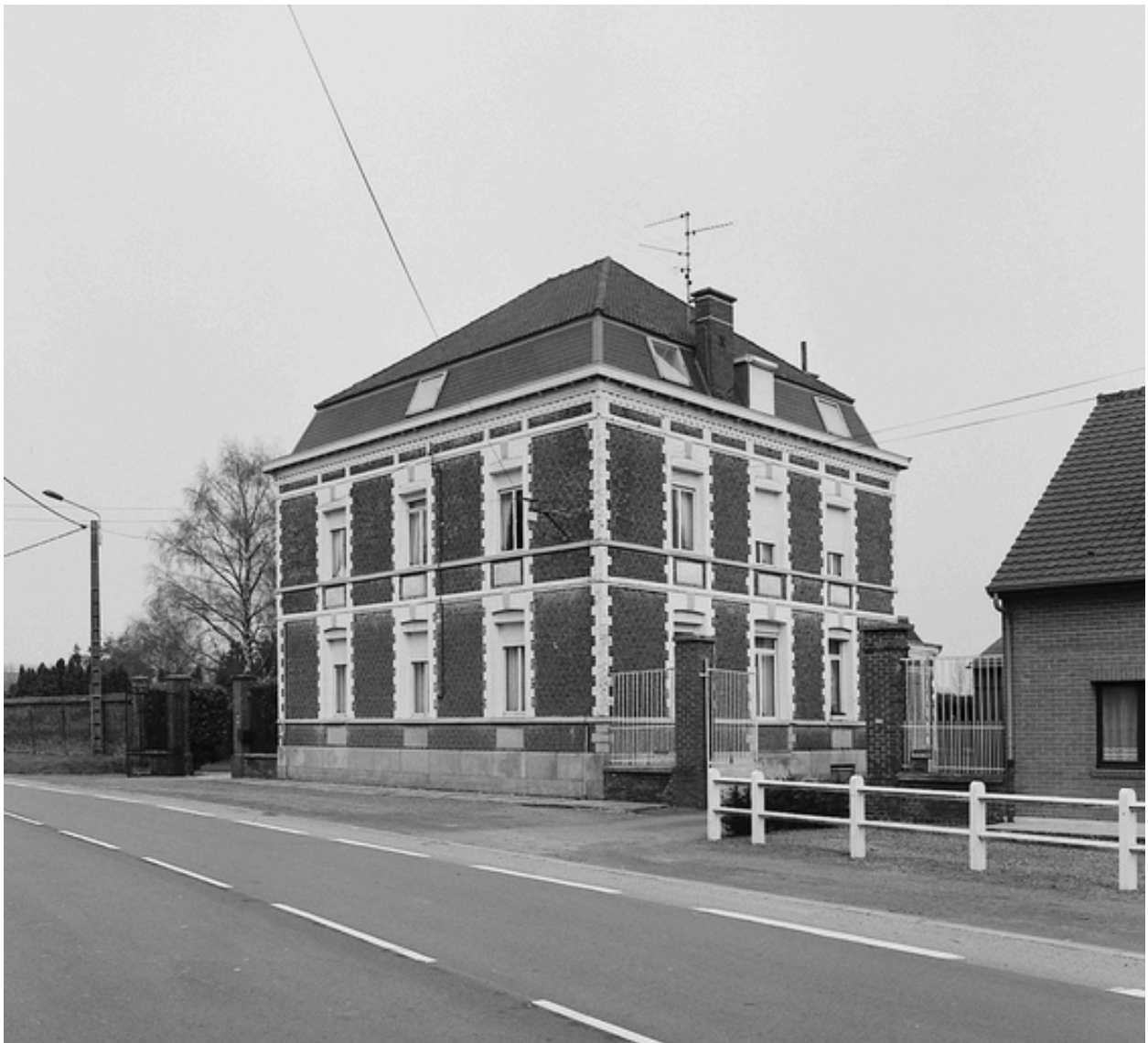
Ferme, 1608 route de Tournai, vue générale du logis.
