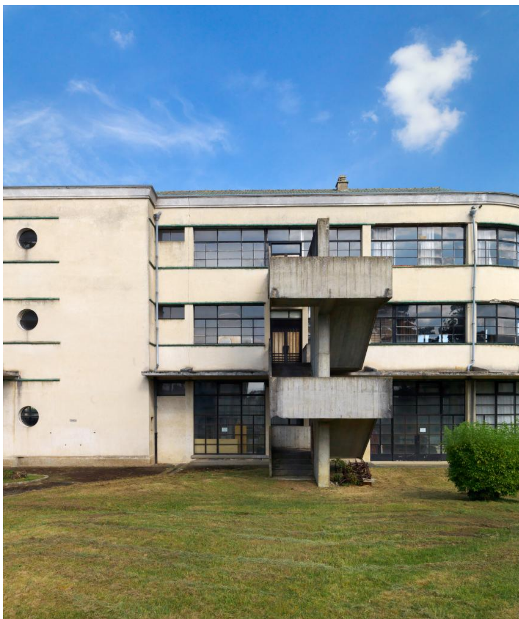
Façade ouest, vue partielle.
