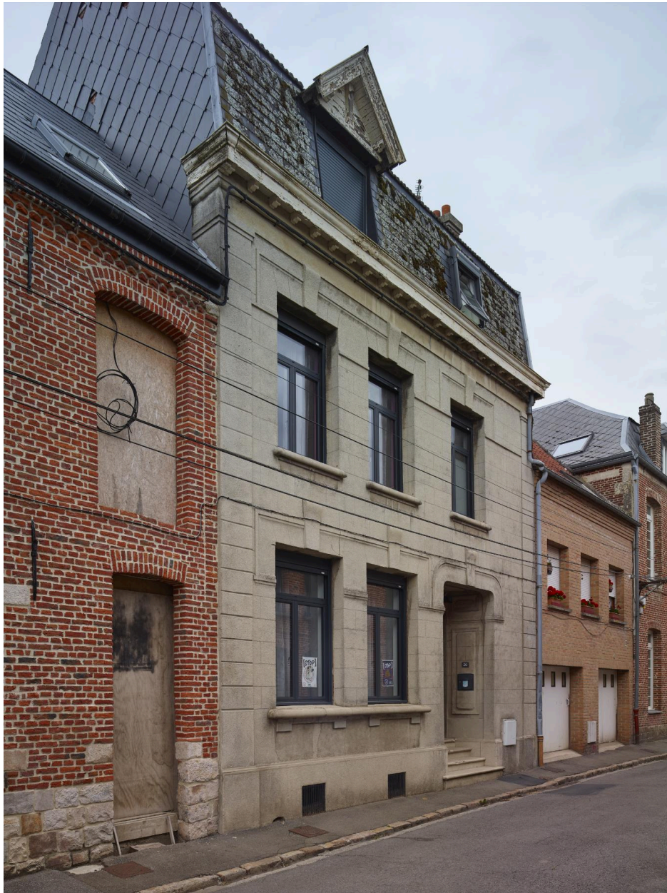
Façade principale. Vue orientée est/ouest.
