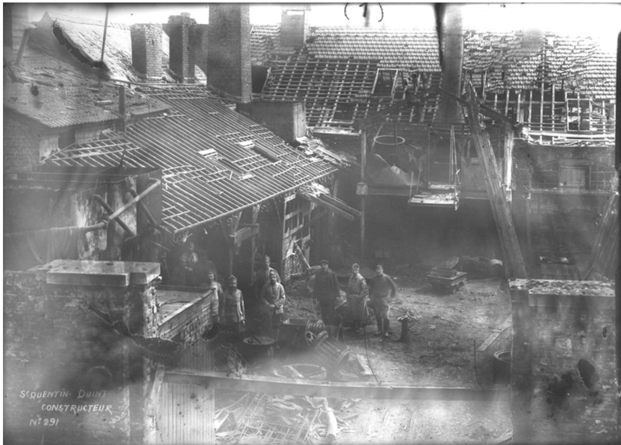
Les ateliers de la rue Bisson, vers 1919 (AD Aisne).
