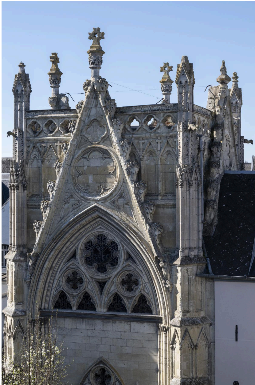
Détail de la partie haute de la façade du chœur, côté est.
