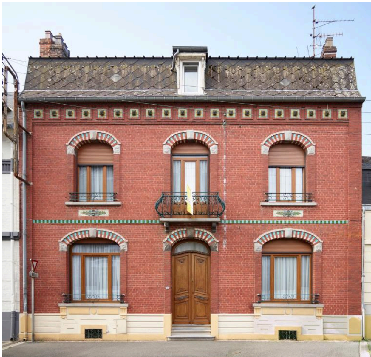
Maison, n°8 rue Leconte. Façade principale depuis la rue. Décors de briques vernissées, de plaques émaillées et de cabochons émaillés.
