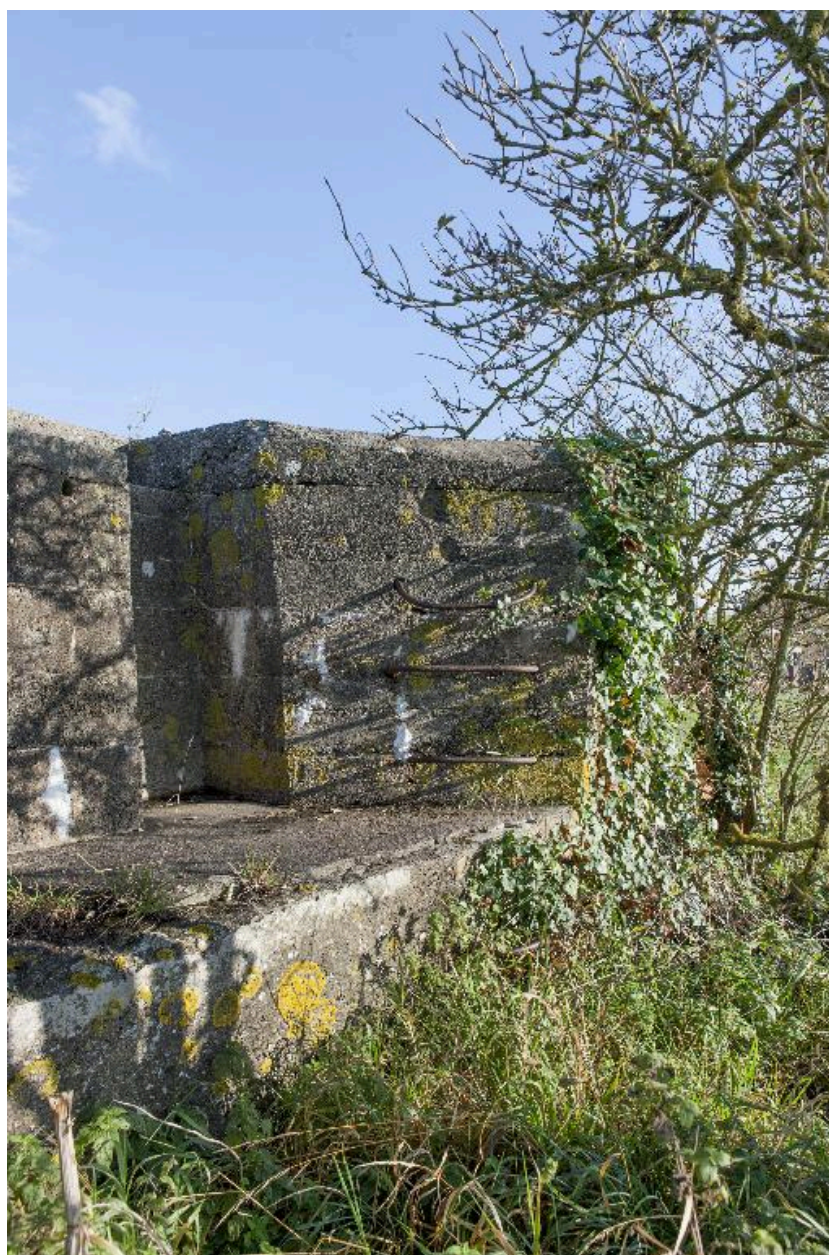
Echélons métalliques donnant accès au couvrement
