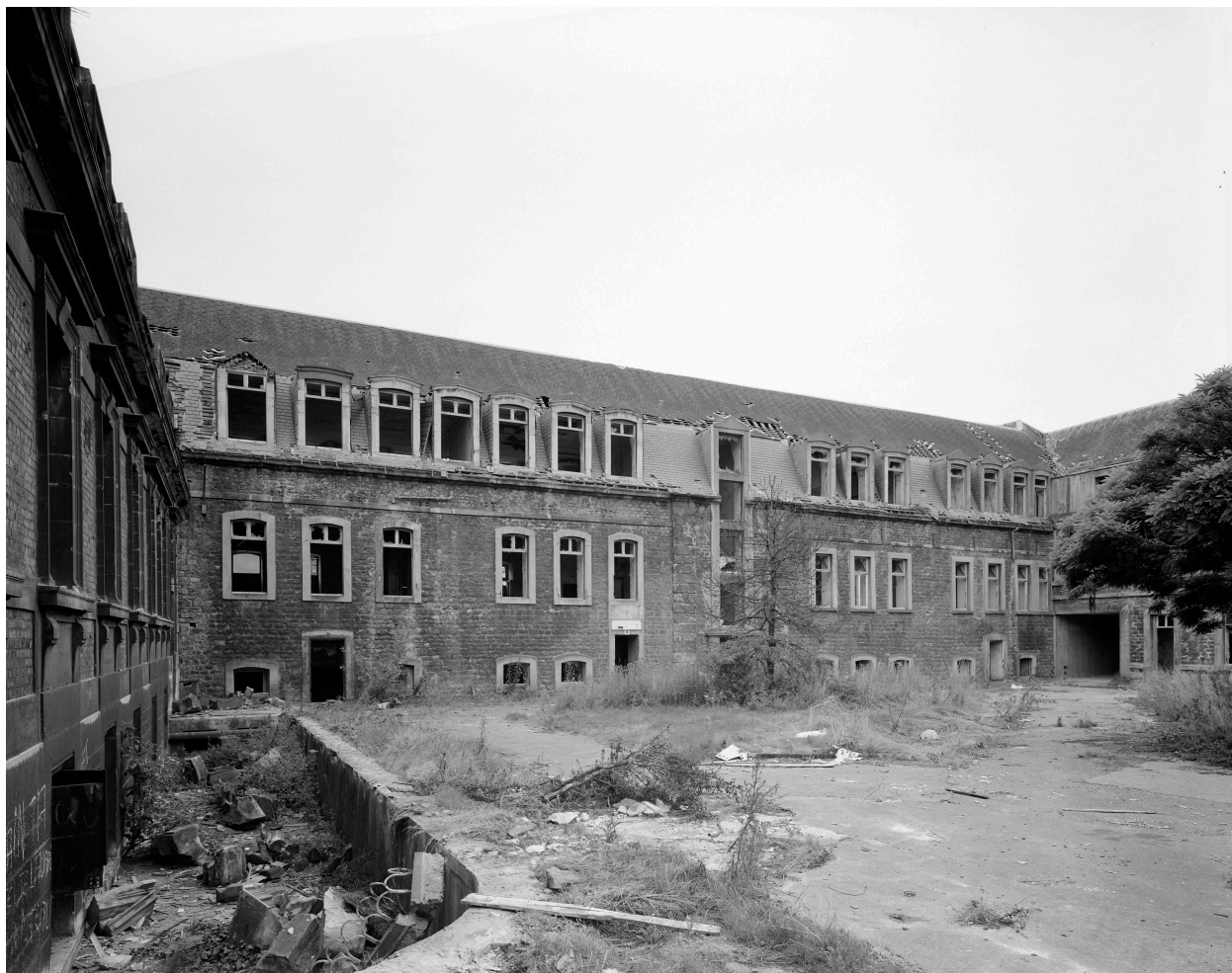
Bâtiment D, façade sur cour.
