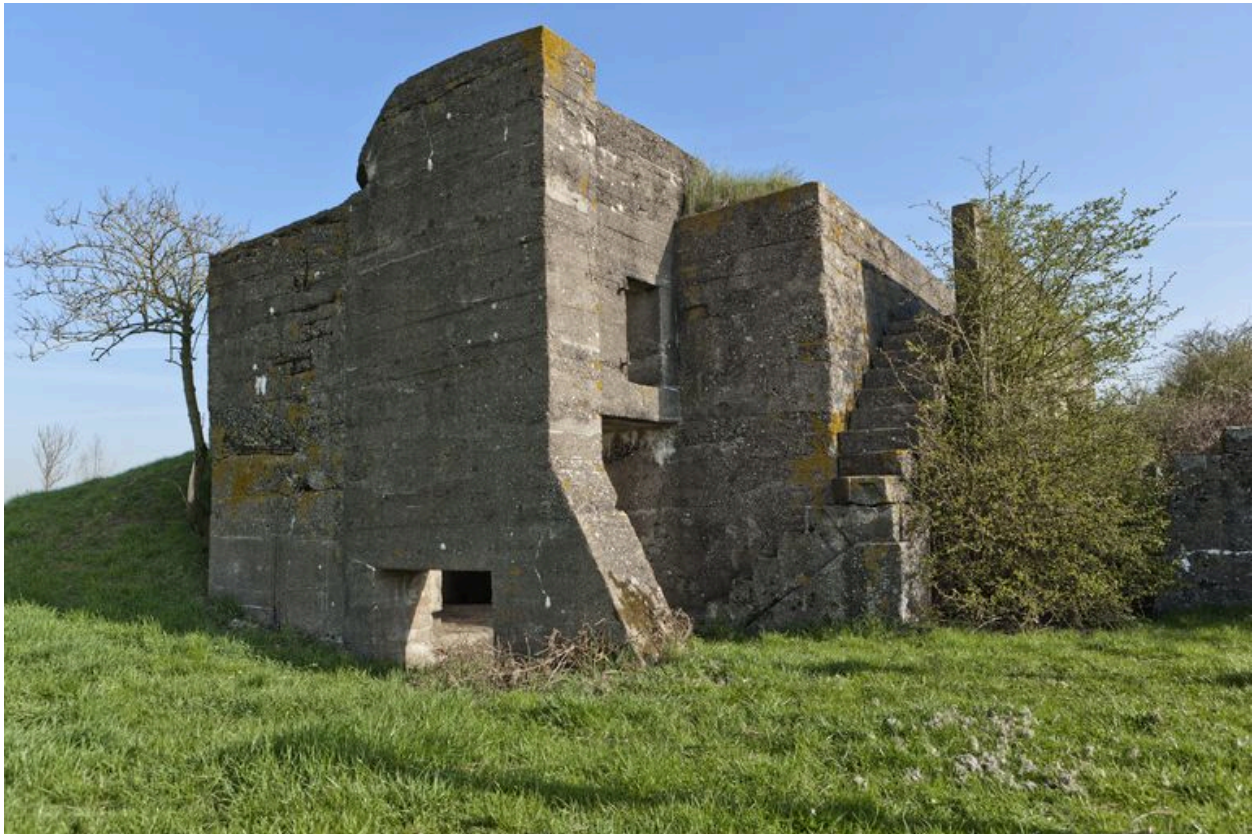
Vue vers le nord-est. Entrée, à gauche, accès à l'observatoire bétonné et escalier menant à la tranchée surélevée
