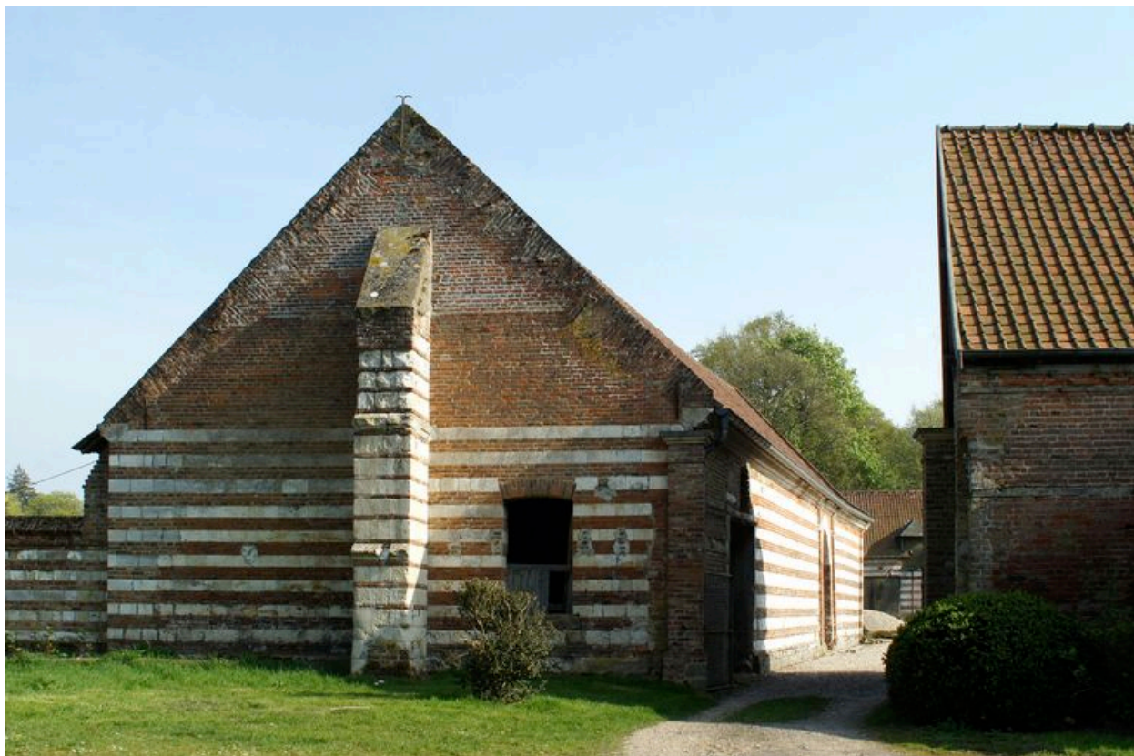
Mur-pignon et contrefort extérieurs de la grange.
