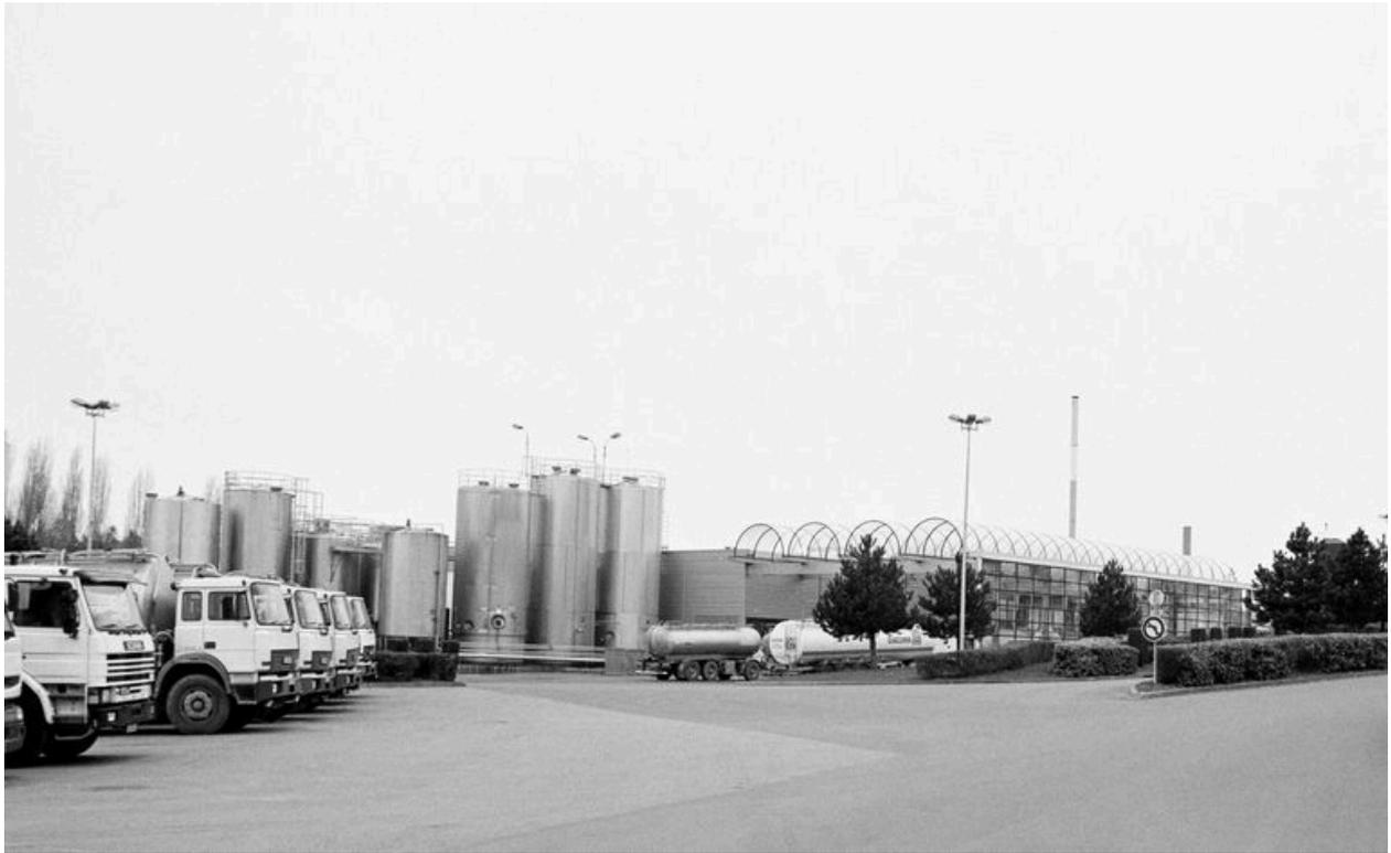
Vué générale du bâtiment de réception du lait, dit hall de dépotage et des réservoirs industriels de stockage de lait depuis le stationnement des camions de ramassage.
