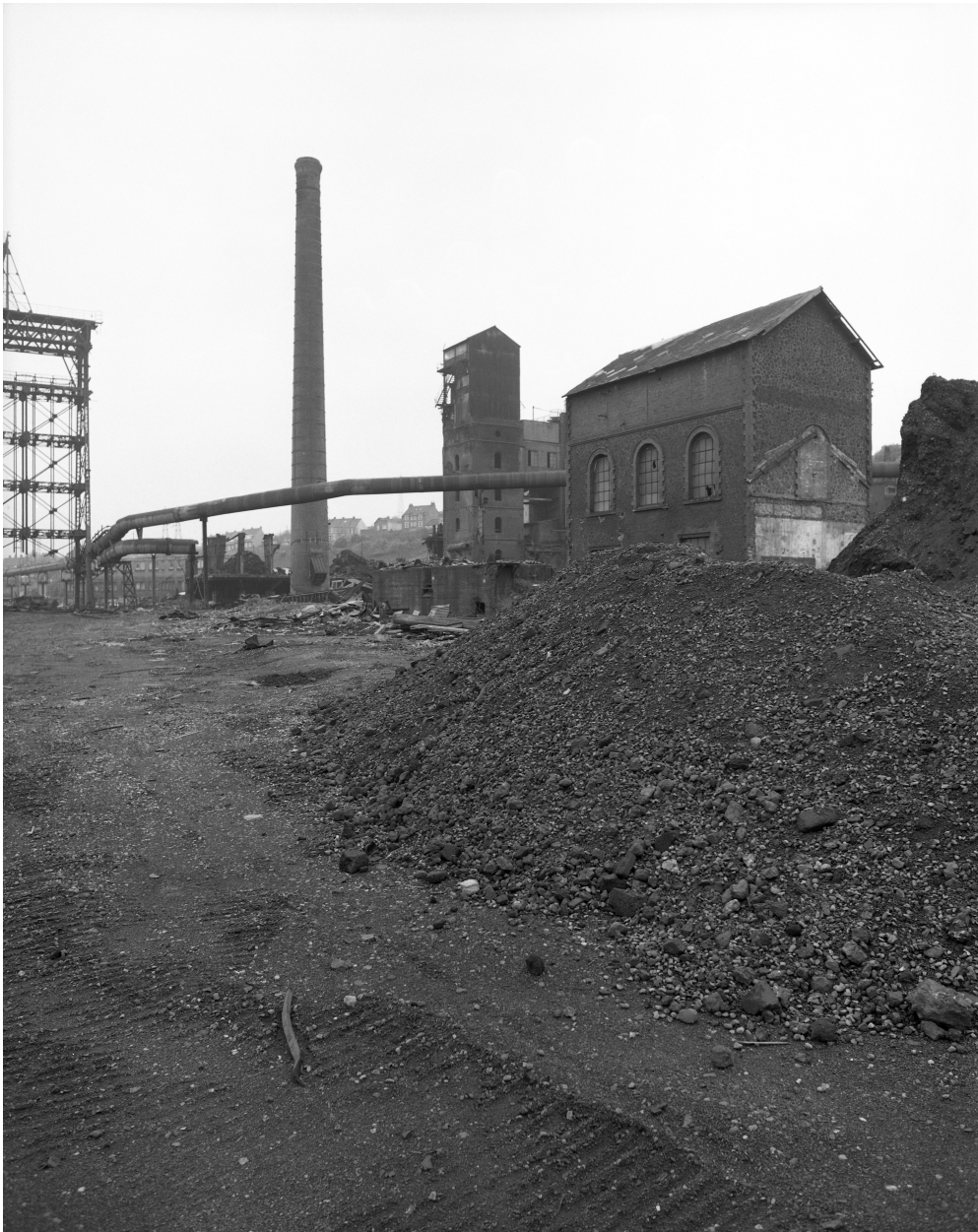
Vue d'ensemble nord (chaudronnerie, portique, élévateur, cheminée d'usine).
