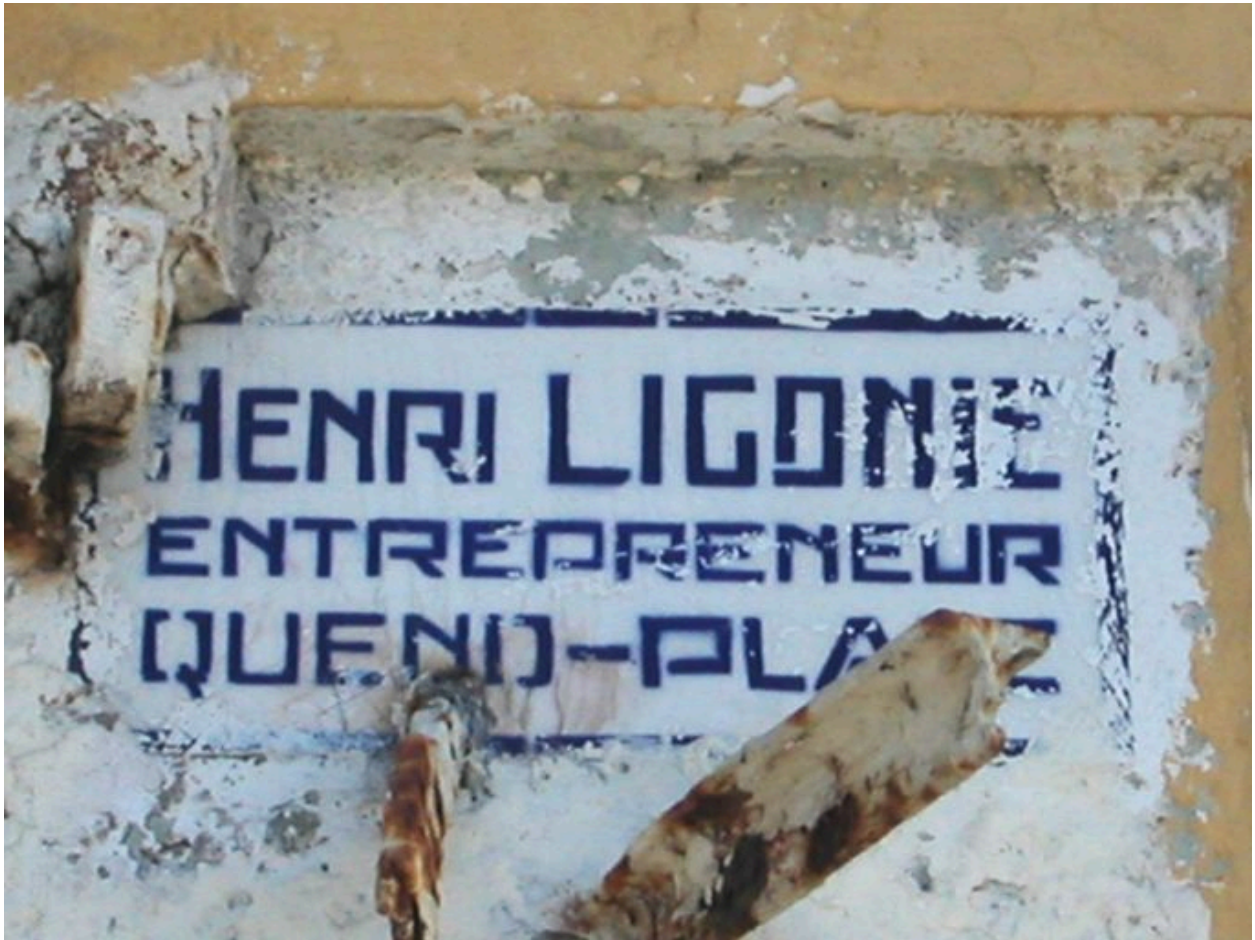
Détail de la plaque portant signature de l'entrepreneur.
