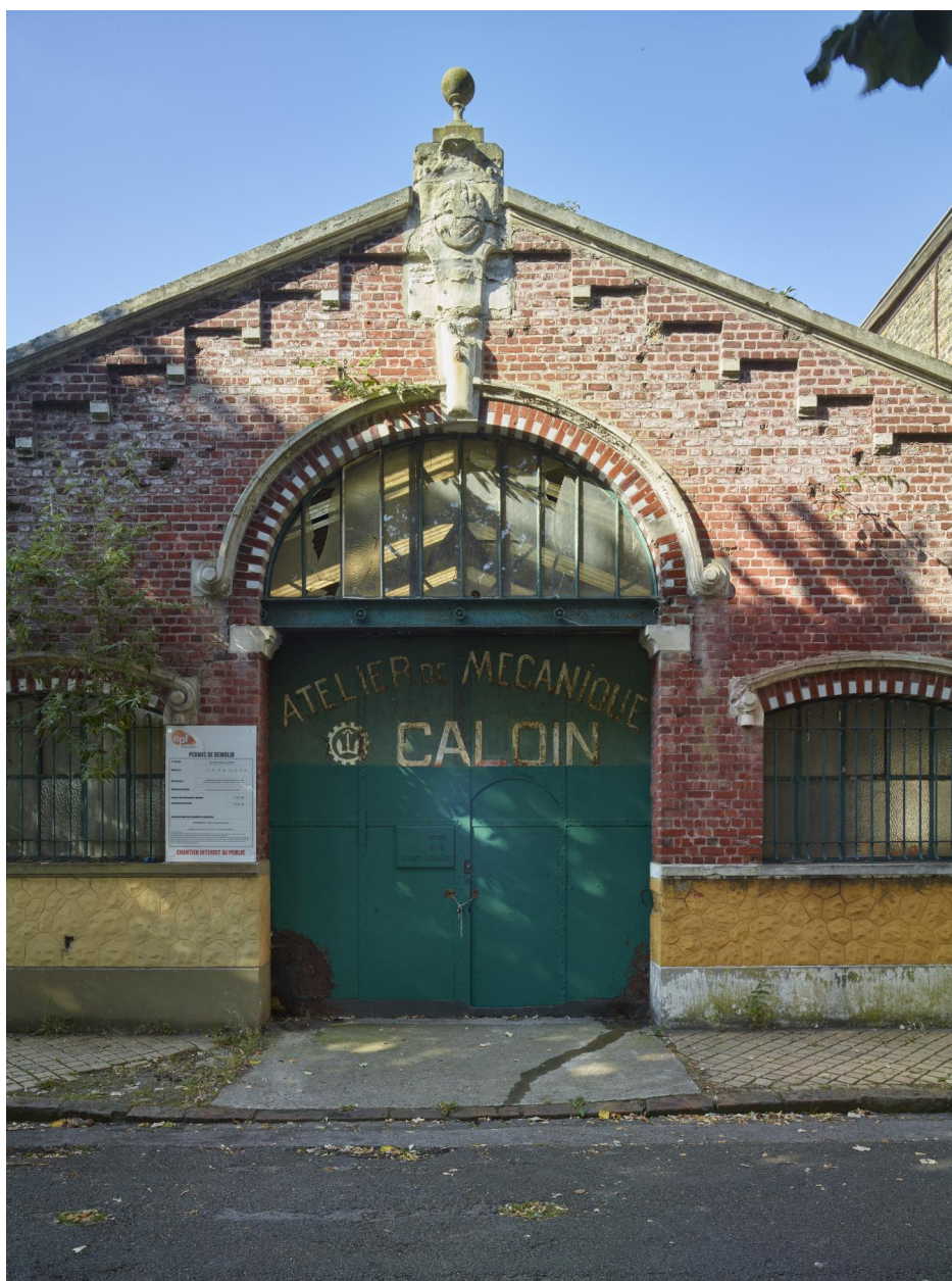
Entrée des ateliers place de l'Europe.
