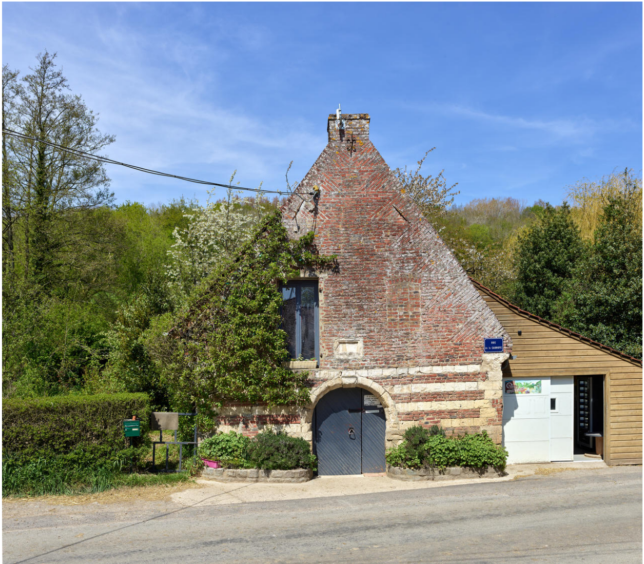
Vue de l'élévation sud en 2023.
