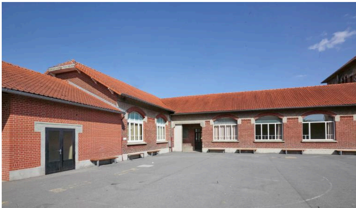
Ecole Carlin, vue des bâtiments sur cour.
